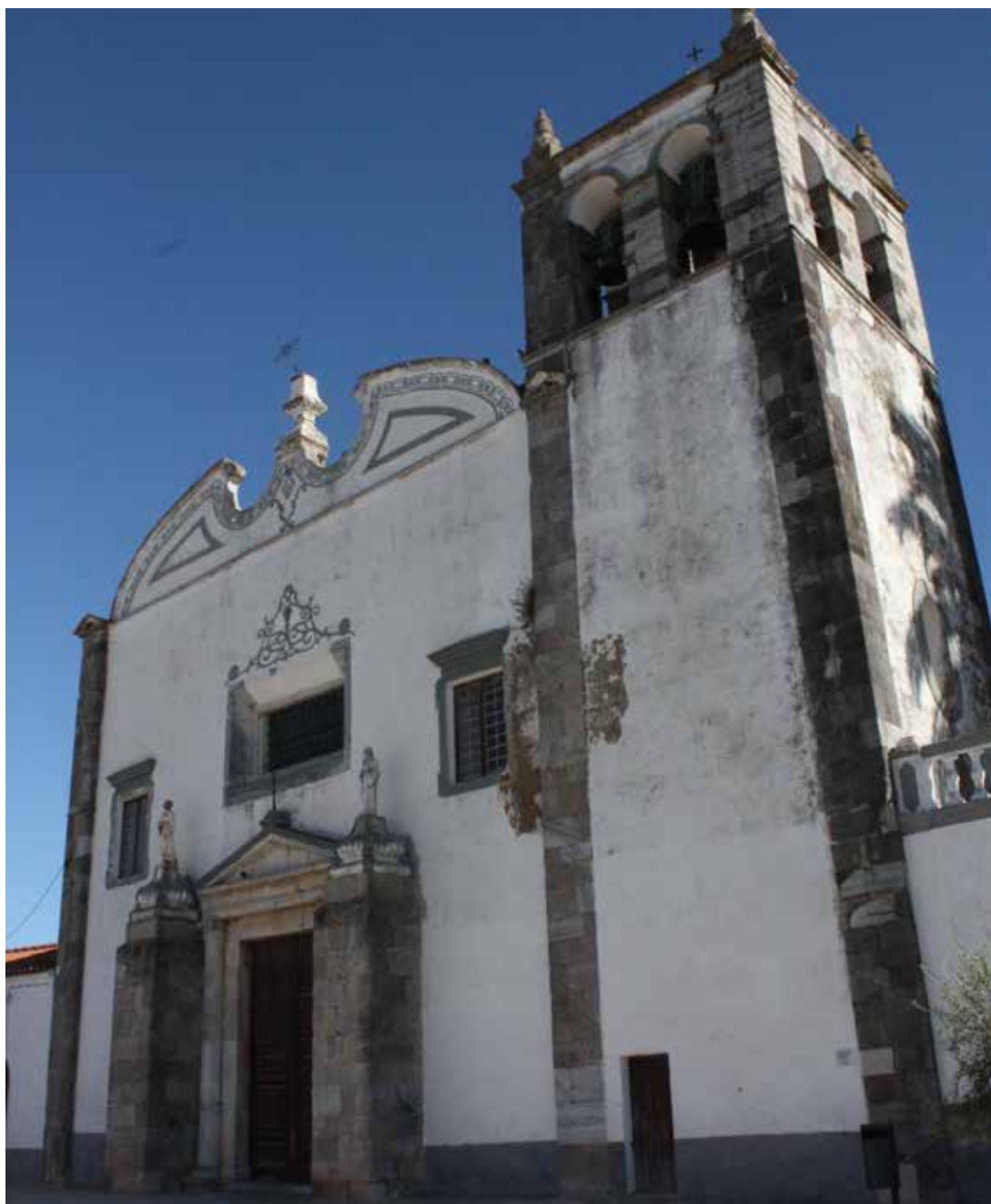
Fachada da Igreja de St.ª Maria
